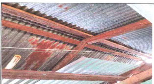
Foto 6: SUSTITUCION DE ESTRUCTURA DE LAMINA.
