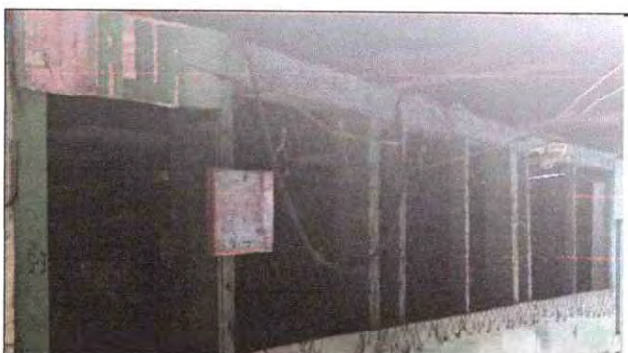
Foto 4: SUSTITUCION DE VENTANAS DE MADERA POR VENTANAS DE METAL CON VIDRIOS.
