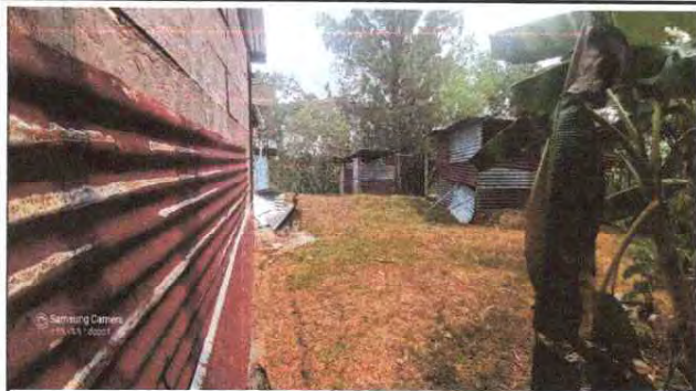
Foto 1: SUSTITUCION DE PARED DE MADERA POR PARED DE BLOCK
