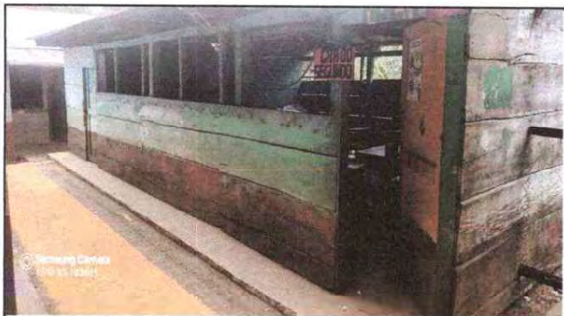
Foto 3: SUSTITUCION DE COLUMNAS Y DE PARED.
